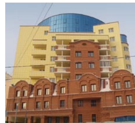
Жилой дом. г. Якутск, пр. Ленина
