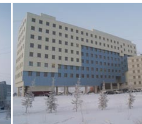
Корпус Технические Факультетов. г. Якутск, ул. Кулаковского, 50
